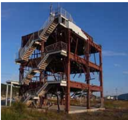
南三陸町志津川の防災対策庁舎跡。屋上に避難した人も押し流されたという。
